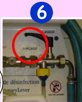
6 Mettre le poste de désinfection en position RINCAGE
