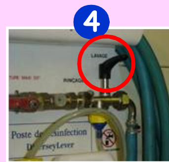
4 Mettre le poste de désinfection en position LAVAGE.
